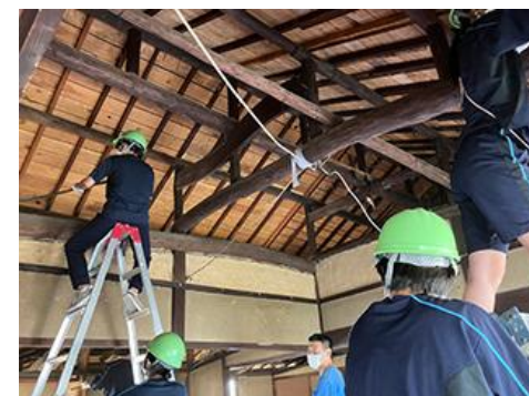
呉市安浦町の空き家改修 工事のお手伝い
